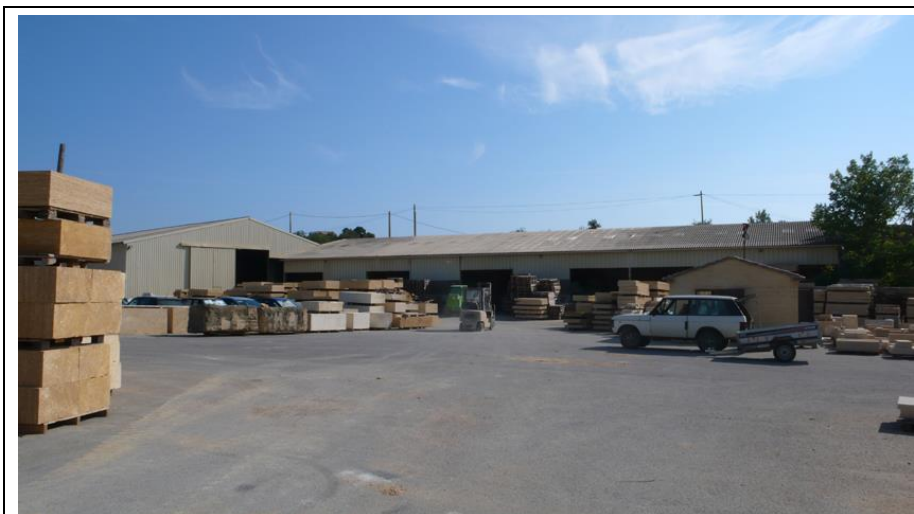
Atelier de sciage de la carrière de la SOC – vue extérieure
